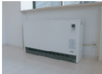
■設備／左：エコキュートと下：蓄熱暖房機を 設置し、家計に優しく、快適に過ごせる住宅です。
