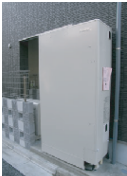
■設備／左：エコキュートと下：蓄熱暖房機を 設置し、家計に優しく、快適に過ごせる住宅です。
