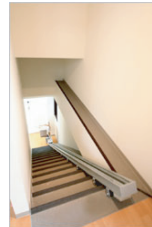
階段は車椅子使用のスタッフのために 階段昇降機を設置
