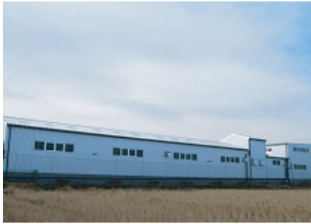
外壁は耐候性に富んだガルバリウム鋼板
