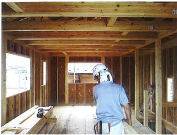
建設中のプラスワン工法住宅
