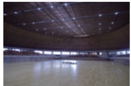
写真-5 ルートCによる耐火建築物 （草薙運動公園体育館）
