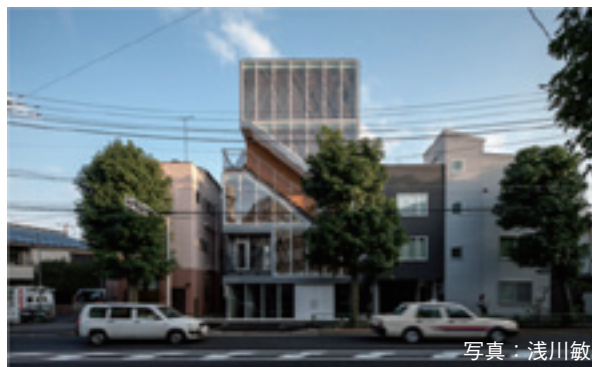
写真-2 5階建て木造共同住宅（1階は鉄筋コンクリート造） （下馬の集合住宅） 写真：浅川敏
