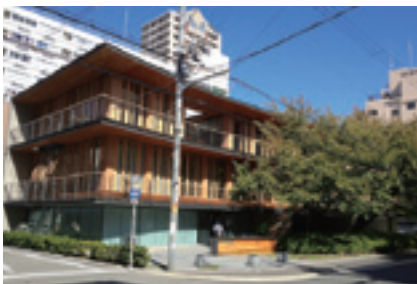
写真-3 燃え止まり型耐火建築物（ルートA） （大阪木材仲買会館）
