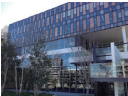
写真-1 6階建て木造庁舎（1～4階は鉄骨造） （埼玉県東部地域振興ふれあい拠点施設）
