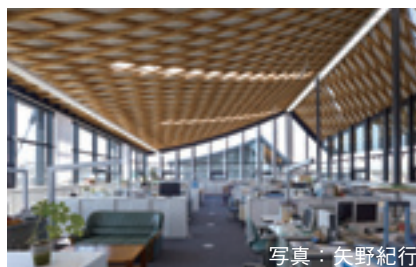
写真-7 屋根木造準耐火建築物1号 （群馬県農業技術センター）
