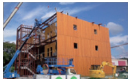
写真-8 木製カーテンウォールによる イ準耐火建築物（鉄骨造）
