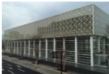
写真-4 鉄骨内蔵型耐火建築物（ルートA） （大分県立美術館）
